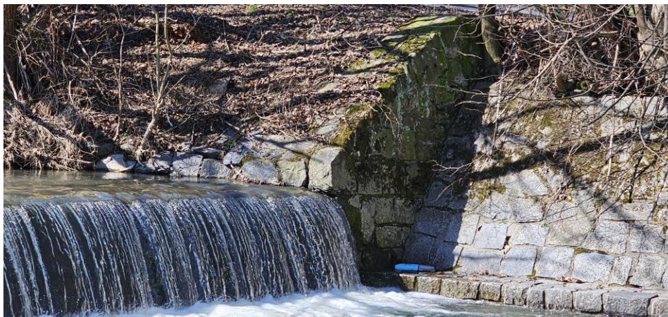
Obrázek 18: pohled na opevnění LB vývaru s patkou (foceno 19.2.2025)
