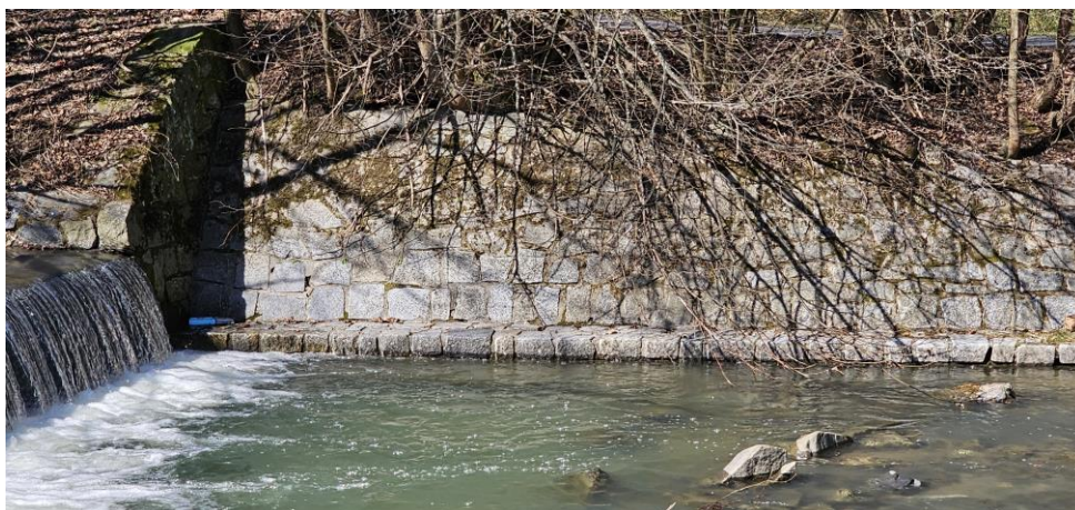
Obrázek 17: pohled na opevnění LB vývaru s patkou (foceno 19.2.2025)
