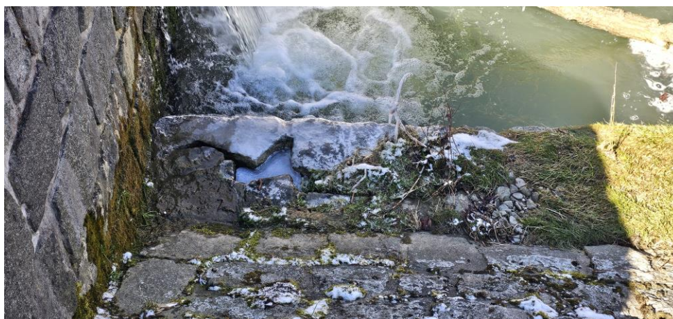
Obrázek 14: pohled na vypadlý obklad PB patky, opevnění břehu vývaru (foceno 19.2.2025)
