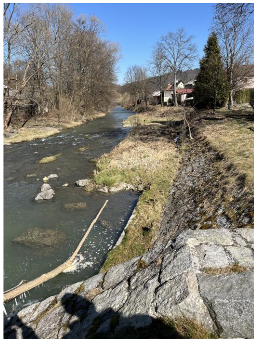
Obrázek 16: pohled na opevnění PB vývaru s patkou (foceno 19.2.2025)
