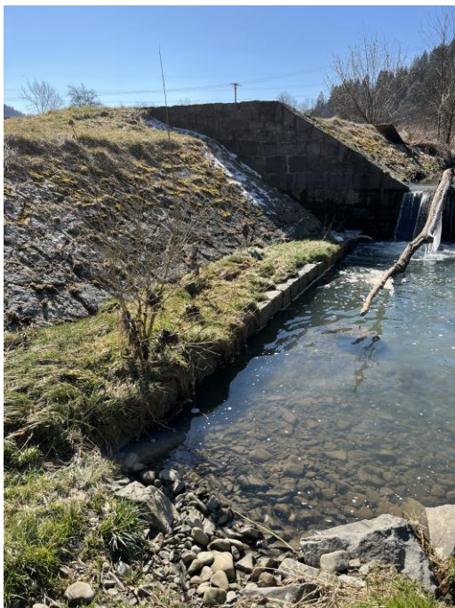
Obrázek 15: pohled na opevnění PB vývaru s patkou (foceno 19.2.2025)
