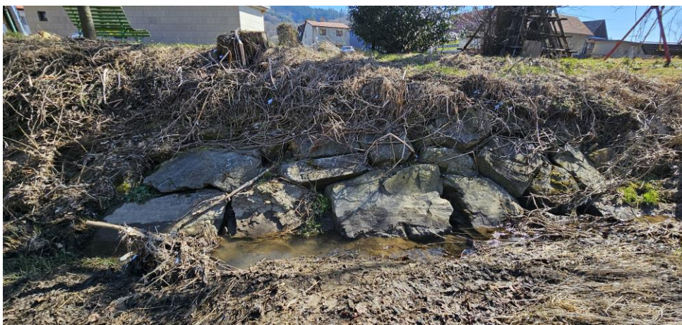
Obrázek 21: opevnění PB za zakončovacím prahem (foceno 19.2.2025)
