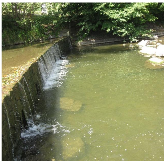
Obrázek 9: Vývar pod stupněm (foceno 19.2.2025)
