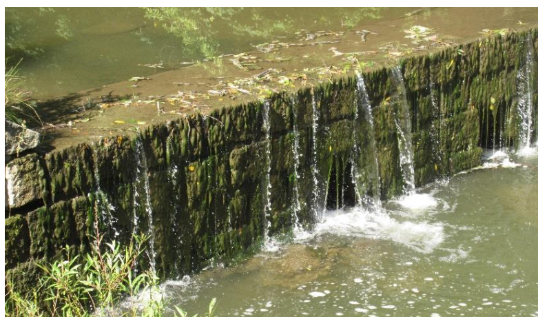
Obrázek 8: pohled na stavební otvory na přelivné hraně. Foto z původní dokumentace 11/2022.
