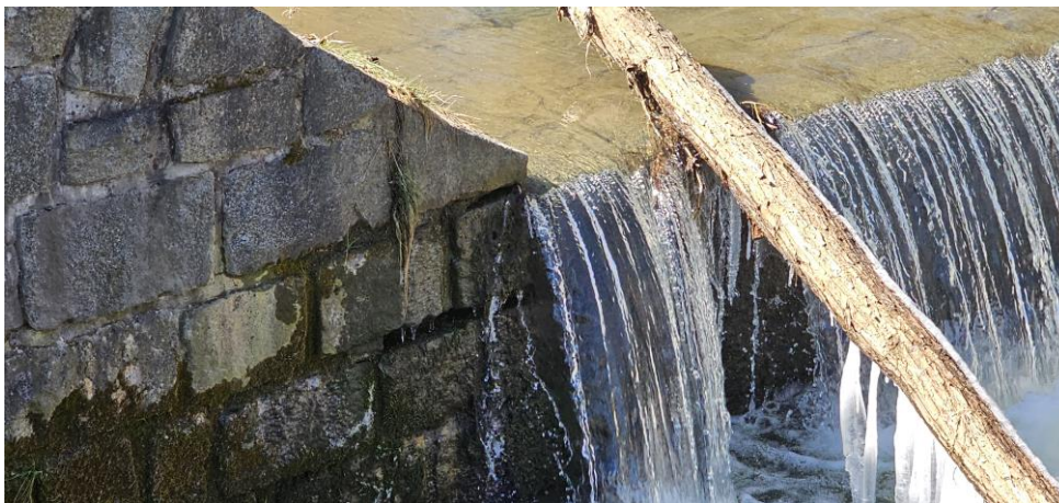
Obrázek 7: pohled na vypadané spáry na čele stupně. Foceno 19.2.2025.
