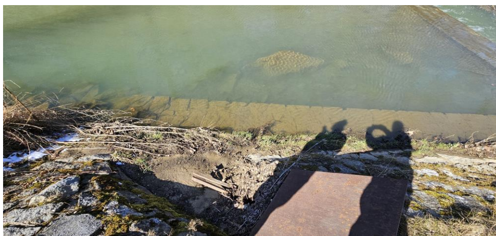
Obrázek 3: opevnění PB nad stupněm opřeno o betonovou patku s obkladem (foceno 19.2.2025)
