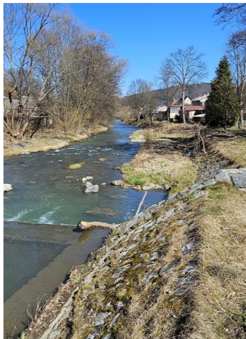
Obrázek 5: opevnění PB nad stupněm opřeno o betonovou patku s obkladem (foceno 19.2.2025)
