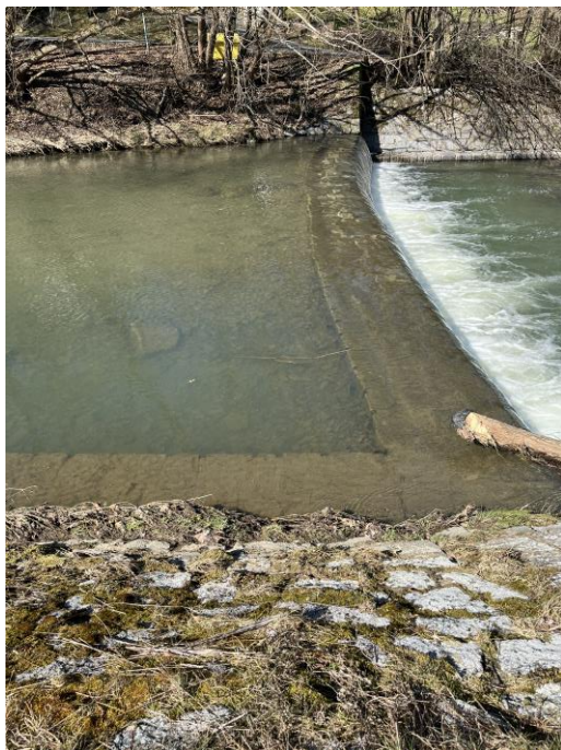
Obrázek 4: opevnění PB nad stupněm opřeno o betonovou patku s obkladem (foceno 19.2.2025)
