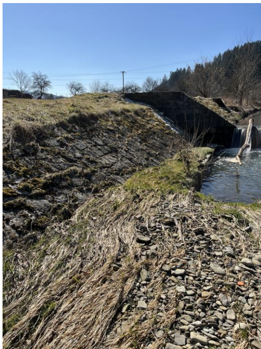
Obrázek 12: pohled na opevnění PB vývaru s patkou (foceno 19.2.2025)
